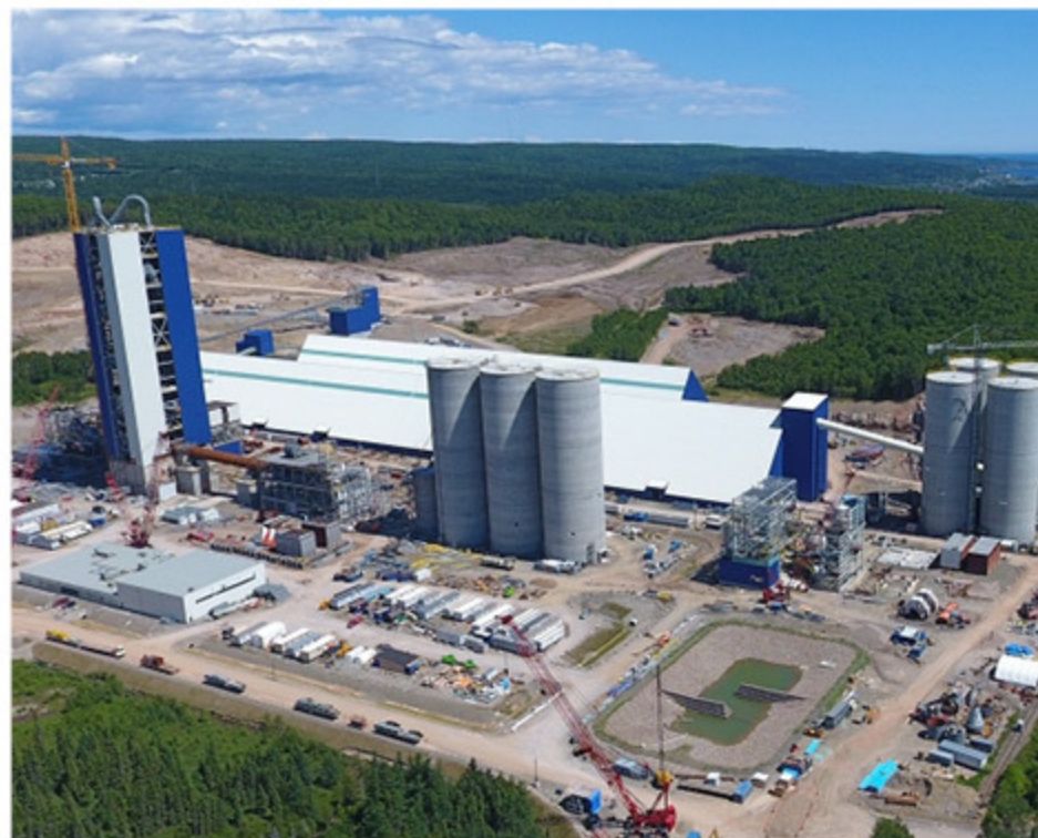
La cimenterie McInnis lors de sa construction. Photo courtoisie — archives
